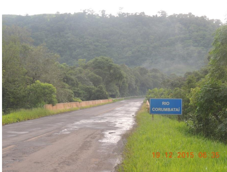
Figura 10 Rodovia BR 487 nas proximidades do barramento da CGH Catuporanga. Coordenadas UTM 423002 m E e 7261068 m S, Fuso 22J. Fonte: Relatório Ambiental Simplificado da CGH Catuporanga (WASSERLAND, 2017a).
